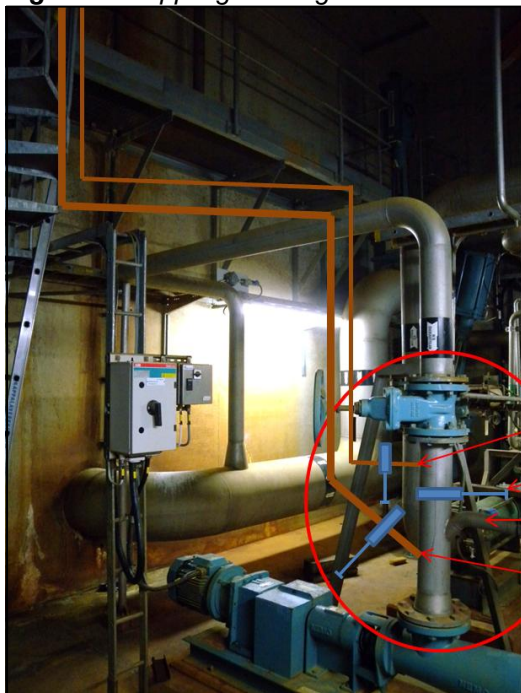
Figur 2. Inkoppling befintligt överskottsslamuttag
