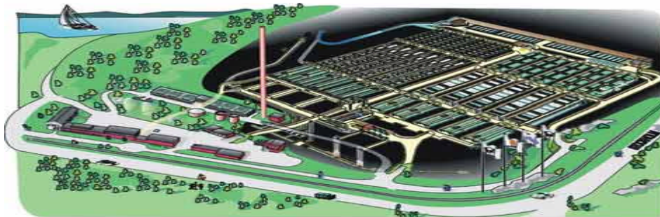
Figur 1. Översiktsbild av Käppalaverket, Lidingö
